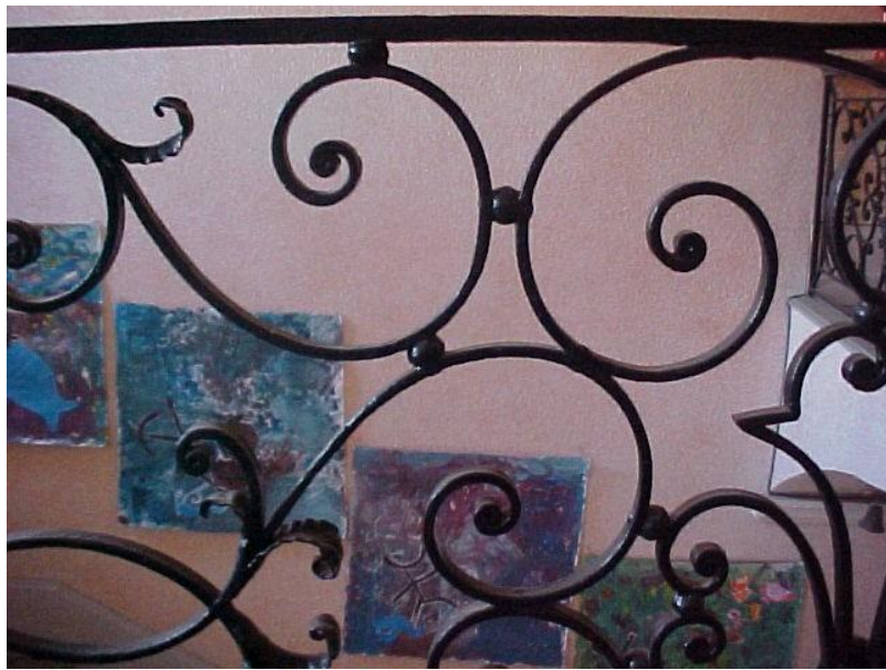
Barrière de l'escalier intérieur d'une école
